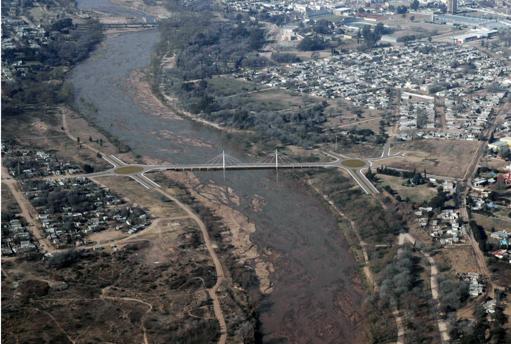
Figura 1. Sitio de implantación del Puente sobre el Río Cuarto
